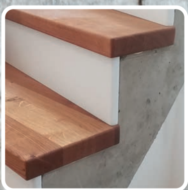
40 mm starke Trittstufen für neue Betontreppen
